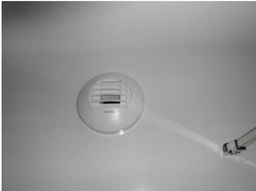
Figure 15 : Bouche d'extraction d'air
