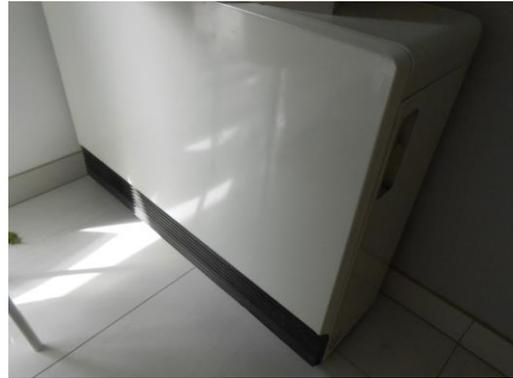
Figure 18 : Radiateur à accumulation
