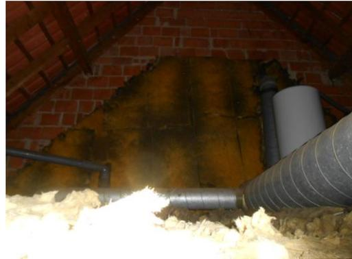
Figure 14 : Réseau de ventilation
